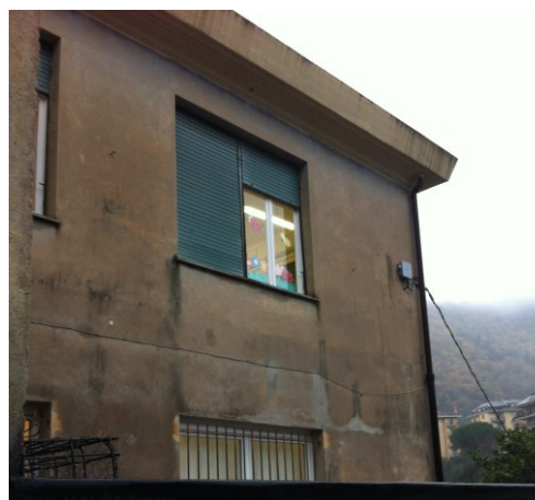
Figura 8.5- Particolare delle murature
