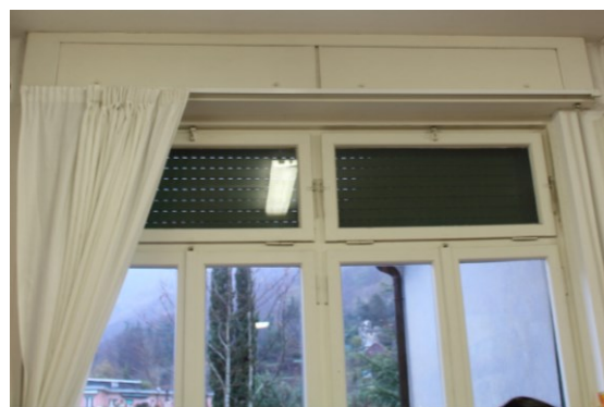
Figura 8.7- Particolare dei serramenti esistenti
