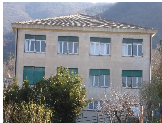
Figura 1.1 - Vista della facciata esposta a ovest
